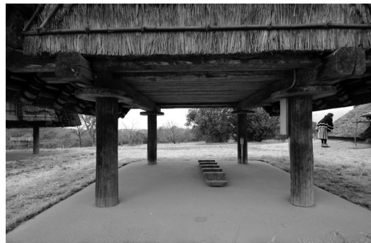
<그림 2> 일본 요시노가리 유적 고상건물 기둥상부구조 상세
