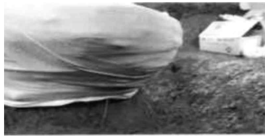
<사진 10> 하부 우레탄붕대 보강
